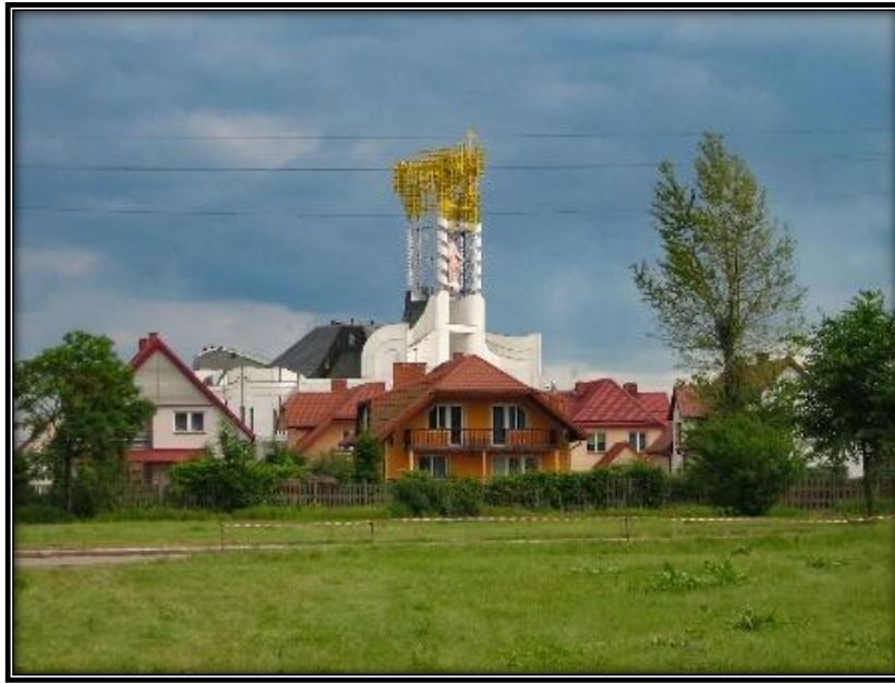
Kościół pw. Matki Bożej Nieustającej Pomocy w Grajewie
